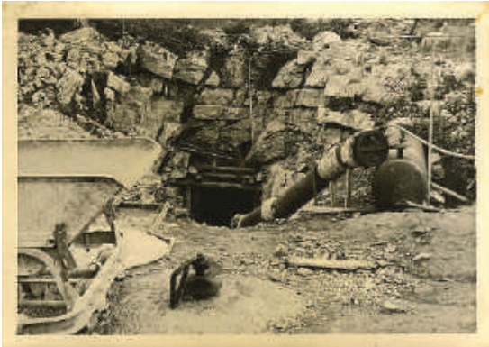
Perçement du tunnel d'accès
